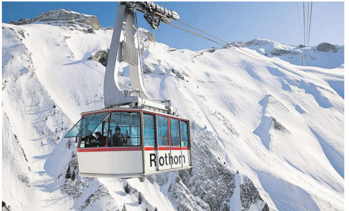
Die Tage der 1971 in Betrieb genommenen Luftseilbahn von Sörenberg auf das Briener Rothorn sind gezählt.
